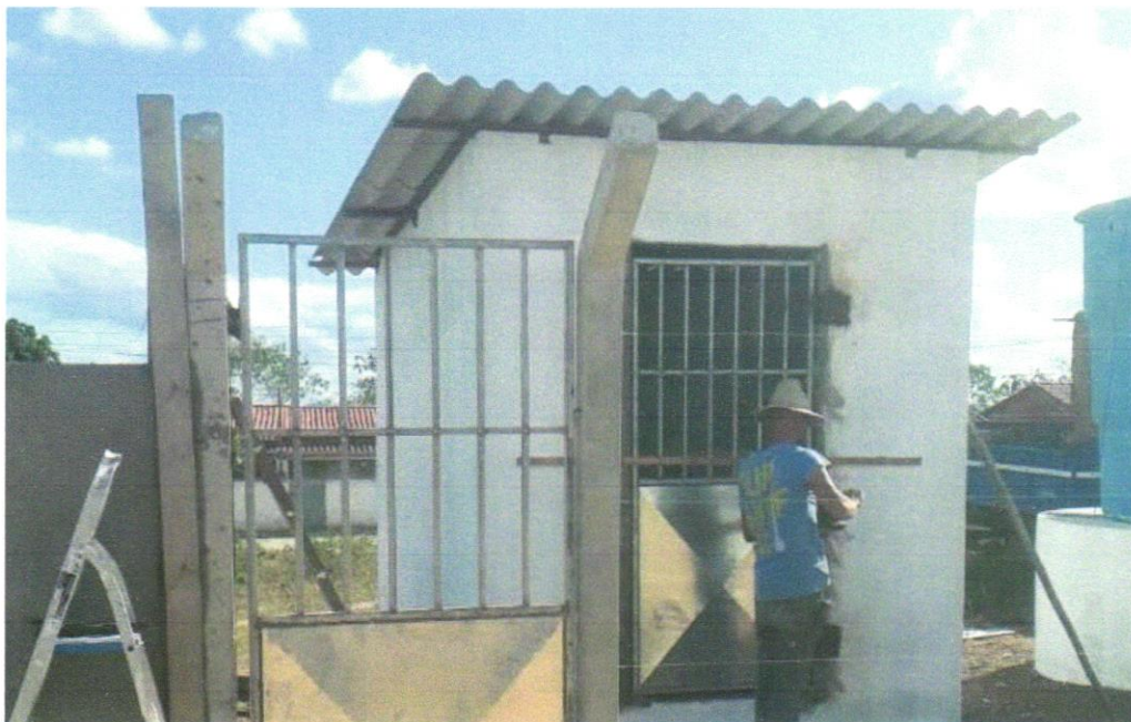
Foto 13 - TELHAMENTO COM TELHA DE FIBROCIMENTO
