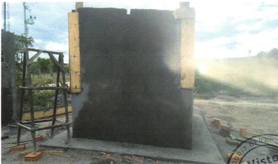
Foto 12 - EMBOÇO, PARA RECEBIMENTO DE CERÂMICA, EM ARGAMASSA TRAÇO 1:2:8, PREPARO MANUAL, APLICADO MANUALMENTE EM FACES INTERNAS DE PAREDES, PARA AMBIENTE COM ÁREA ENTRE 5M2 E 10M2, ESPESSURA DE 20MM, COM EXECUÇÃO DE TALISCAS. AF_06/2014
