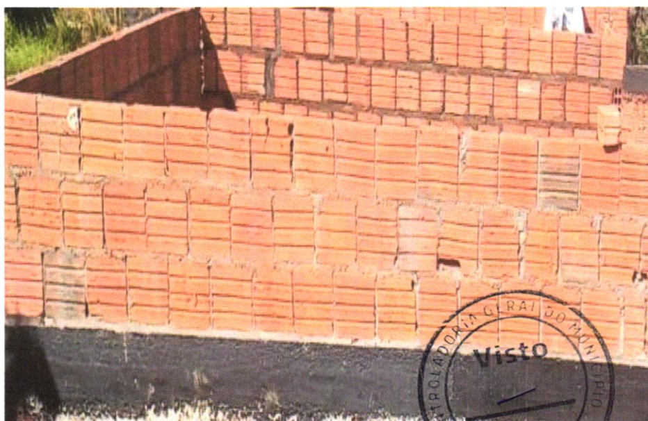
Foto 06 – IMPERMEABILIZAÇÃO DE SUPERFÍCIE COM EMULSÃO ASFÁLTICA, 2 DEMAOSAF_06/20
