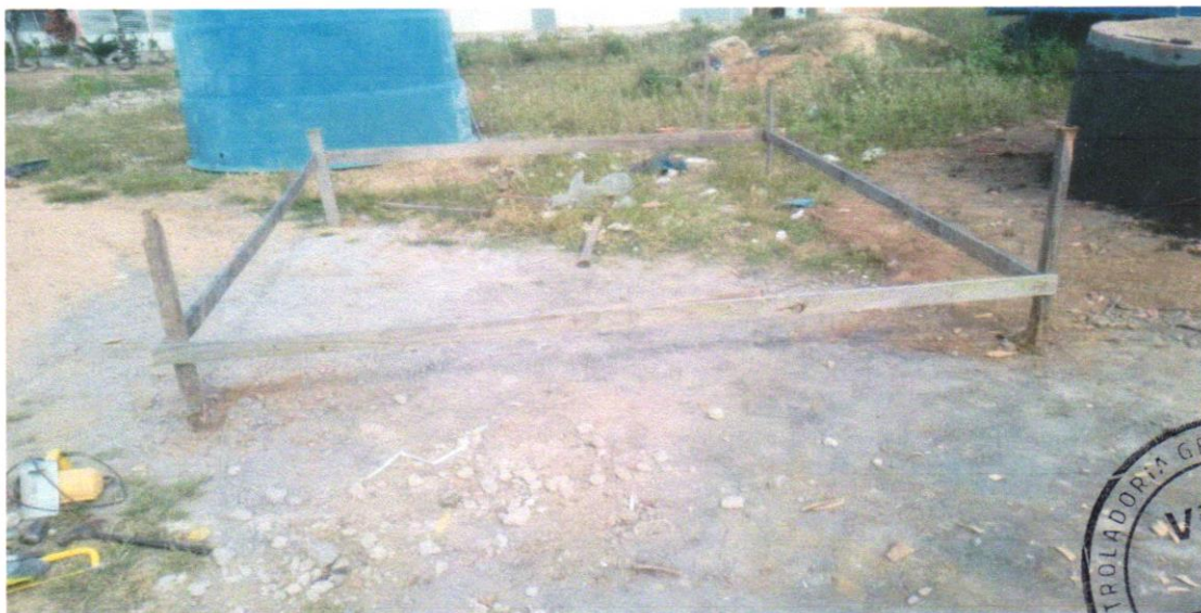
FOTO 02 – LOCAÇÃO CONVENCIONAL DE OBRA, UTILIZANDO GABARITO DE TÁBUAS CORRIDAS PONTALETADAS A CADA 2,00M - 2 UTILIZAÇÕES. AF_10/
