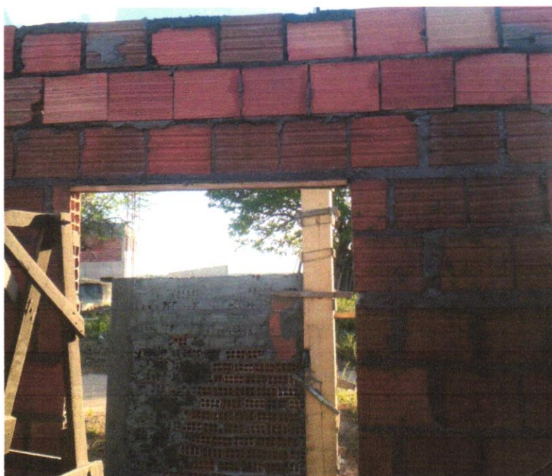
FOTO 18 –ALVENARIA DE VEDAÇÃO DE BLOCOS CERÂMICOS FURADOS NA HORIZONTAL DE 9X19X19CM (ESPESSURA 9CM) DE PAREDES COM ÁREA LÍQUIDA MENOR QUE 6M² SEM VÃOS E ARGAMASSA DE ASSENTAMENTO COM PREPARO EM BETONEIRA.
